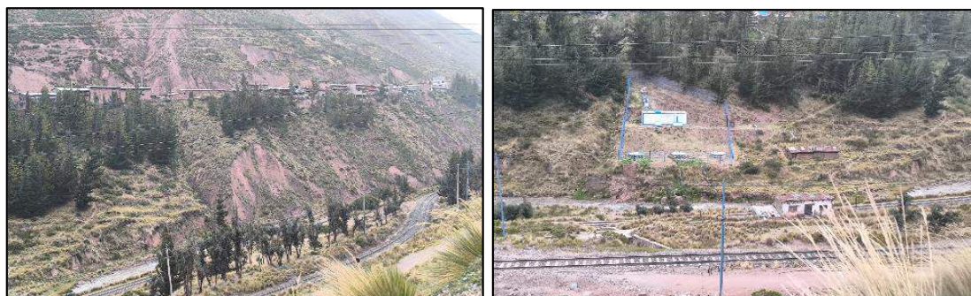
IMAGEN 02: SE OBSERVA MARGENES CON EROSION LATERAL Y LA PRESENCIA DE RED FERROVIARIO VULNERABLE EN CASO DE AVENIDAS (CRECIDA) DEL RIO.
